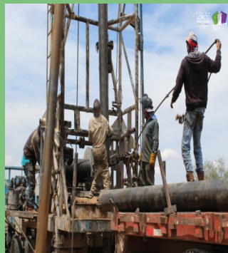
COLOCACIÓN DE TUBERÍA PARA LA CONSTRUCCIÓN DEL POZO DE AGUA POTABLE EN LA COMUNIDA DE BIMBALETES
