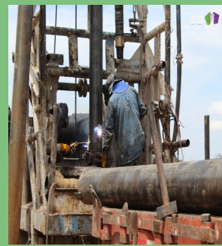
COLOCACIÓN DE TUBERÍA PARA LA CONSTRUCCIÓN DEL POZO DE AGUA POTABLE EN LA COMUNIDA DE BIMBALETES
